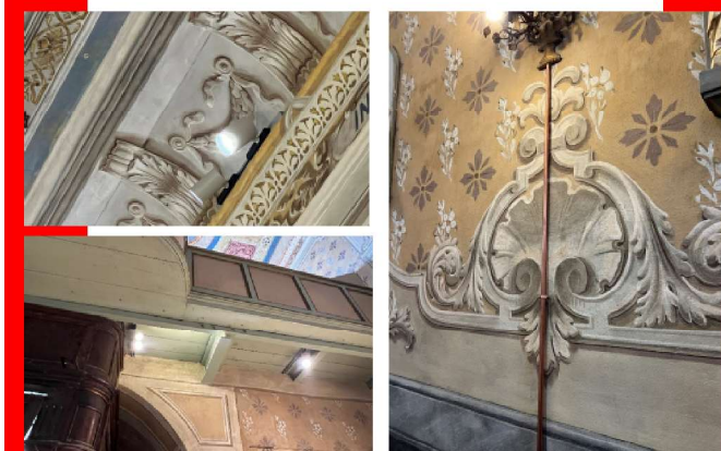
Installati canaline e nuovi punti luce
